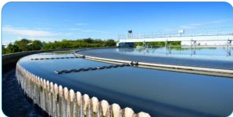
Avløp og renseanlegg
